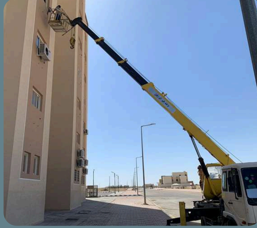
استخدام شاحنات مناسبة للنقل بشكل آمن
